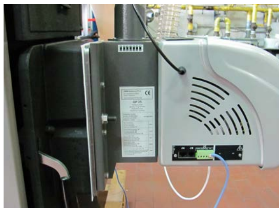
Рис. 25 Крепеж горелки
