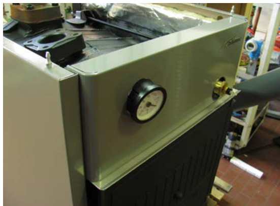
Рис. 28 Снять термометр
