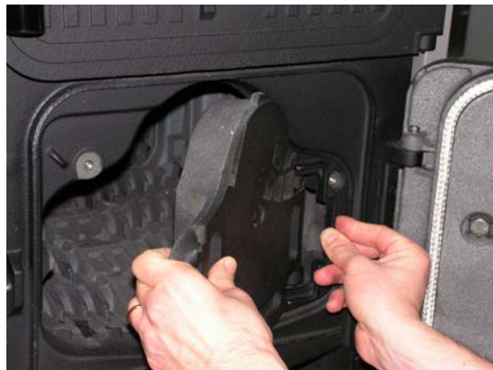
Рис. 14 Снятие решетки
