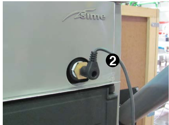
Рис. 33 Разъем предохранительного термостата
